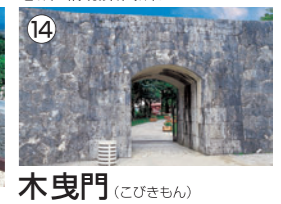
14 木曳門 (こびきもん) 王朝時代、首里城の建物の建設や修理、石積修復工事の資材搬入時に使用され、普段は石を詰めて閉じられていました。現在は見学ルートの入口。
